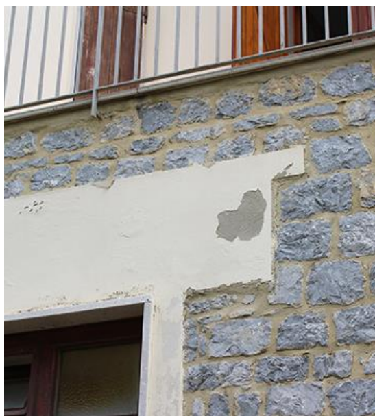
Fig. 4 - dettaglio degrado, esfoliazione pitture
