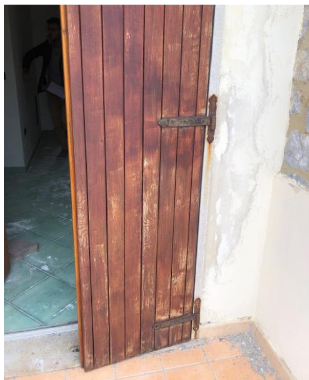
Fig. 7 - dettaglio degrado, legni e manovre
