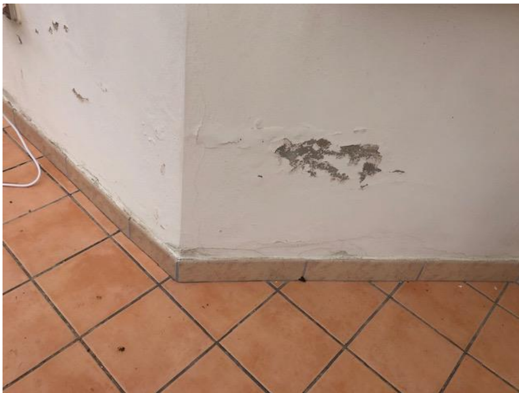
Fig. 8 - dettaglio degrado, umidità per risalita
