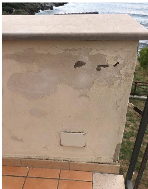
Fig. 12 dettaglio degrado, efflorescenze saline
