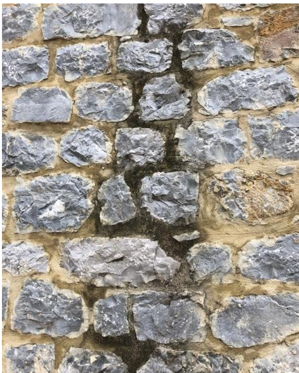
Fig. 11 dettaglio degrado, muschi
