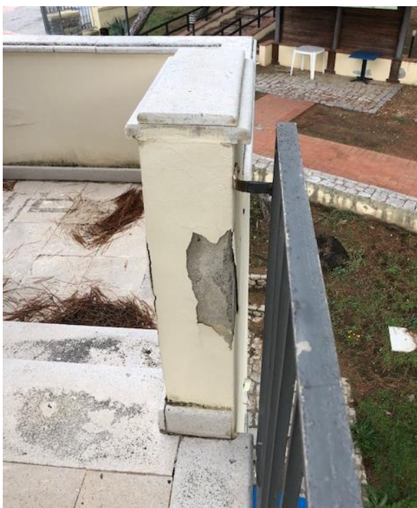
Fig. 6 - dettaglio degrado, rigonfiamenti intonaci
